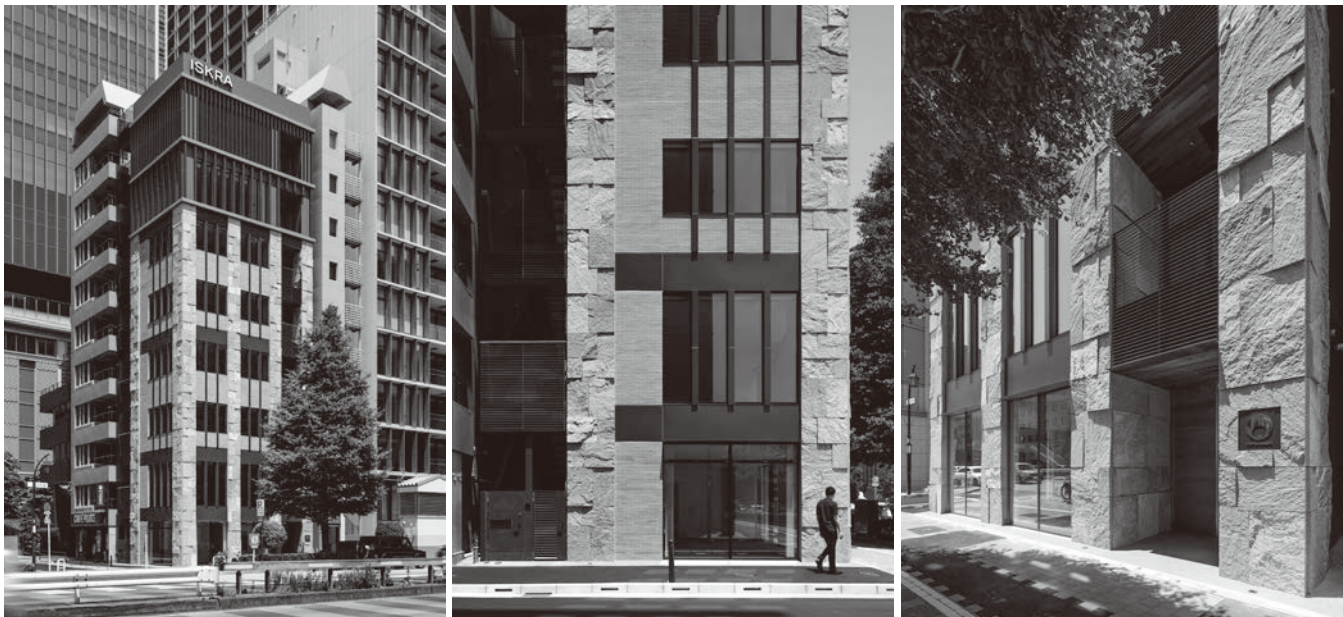
イスクラ産業(株)本社ビルの外観。庵治石割肌の板材(最大で長辺約100cm、厚み約30～80mm)で1階から6階までを貫く5本の石柱をつくり、大地とつながる重厚感、温かさを表現。日本橋高島屋の近隣、昭和通りに面した一等地で石本来の美しさ、力強さを強烈に発信している photos: イメージグラム
