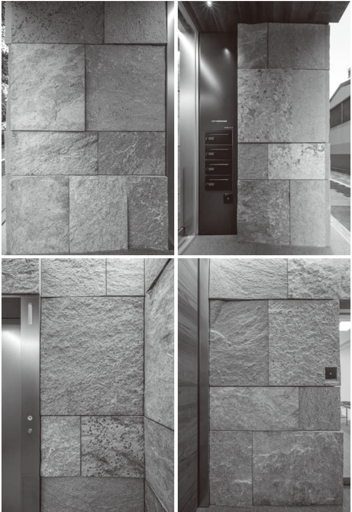
イスクラ産業(株)本社ビルの庵治石割肌。外壁同様に多種多様な石肌が見られ、まるで庵治石の標本室。 1-2 エントランス。 3-4 1階エレベーターホールの壁
