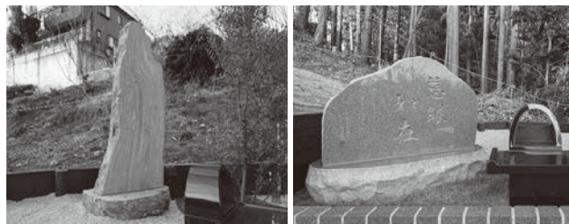
「オリーブの丘」に新設された合祀墓(左は伊予青石製)。合祀墓の地中など随所に木杭を打設し、地盤強化を図る
