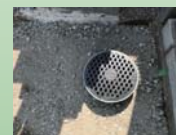
排水設備工事 浸透柵、蓋設置
