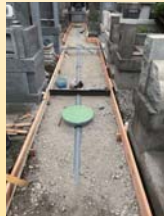
通路型枠、EPJ目地 ワイヤーメッシュ敷 浸透柵敷設 オーバーフロー管敷設
