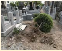
敷石撤去作業
