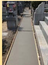
土間コン打設 金鍍均し
