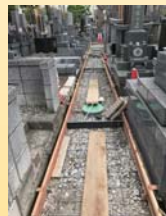
通路型枠、EPJ目地 ワイヤーメッシュ敷
