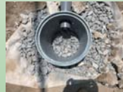
排水設備工事 浸透柵設置
