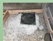
浸透柵、蓋、止め枠設置
