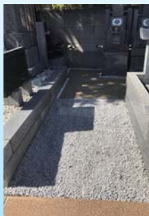
砂利敷仕上げ
