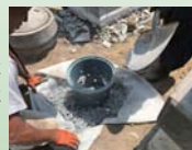
排水設備工事 浸透柵設置
