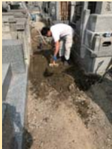
通路掘削作業
