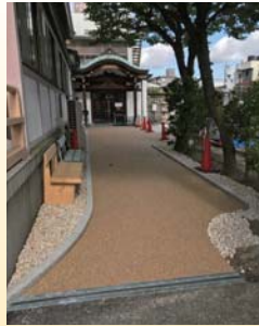
グレーチング施工 本堂脇リンクストーン施工
