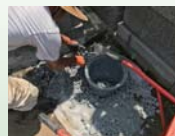
排水設備工事 浸透柵設置
